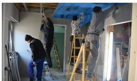
Dela v mansardi gasilskega doma
