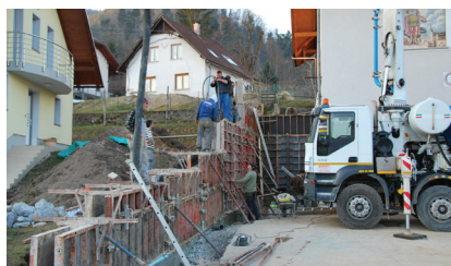
Gradbena dela ob izdelavi opornega zidu [foto: Klemen Zibelnik]
