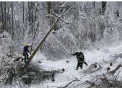
Za pomoč pri popravilu električnih vodov smo uporabili tudi improvizirana orodja [foto: Klemen Zibelnik]
