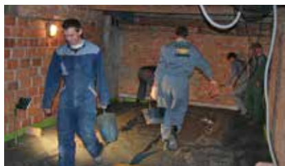
Izdelava estriha nad stanovanjem [foto: Klemen Zibelnik]
